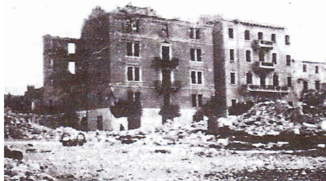
Dopo i bombardamenti, quello che resta. La casa Bottura è quella a destra, palazzo di 5 piani di cui il piano terreno e parte del primo risultano nascosti dalle macerie
